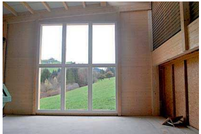
Die neue Produktions- und Lagerhalle verfügt über grossformatige Fenster.
